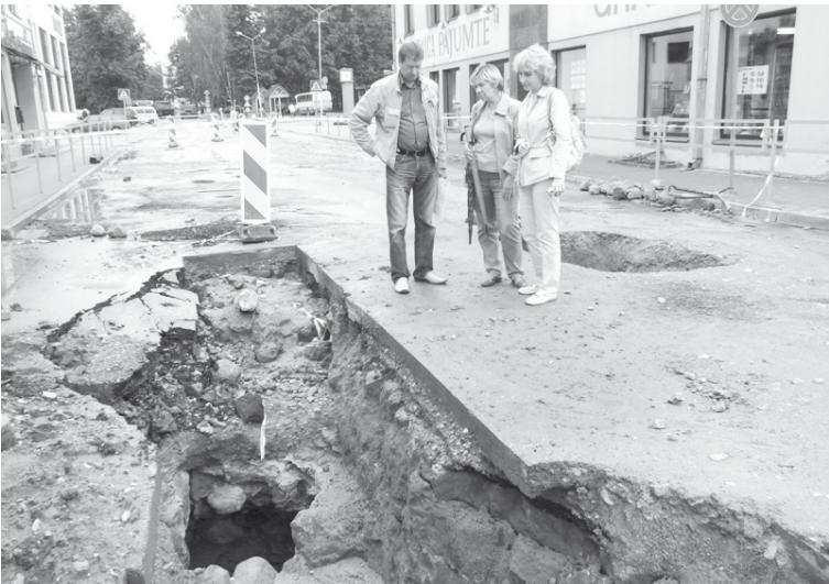
Alūksnes novada pašvaldības būvinženieris Aivars Sausais un VKPAI Vidzemes reģionālās nodaļas pārstāves Ilze Ozola un Dace Ķibilda novērtē lietus ūdens kanalizācijas atsegumu Pils ielā Evitas Aplokas foto
