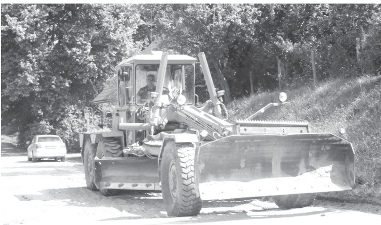
Pirms seguma atjaunošanas sākšanas tika veikta ielu seguma planēšana Evitas Aplokas foto
